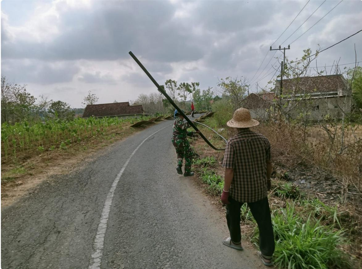
Kegiatan pipanisasi ini merupakan bagian dari program Kemenhan yang melibatkan pemasangan pipa berukuran 2 dim dengan jarak sekitar 1,5 kilometer dalam mendukung pembangunan infrastruktur di daerah terpencil dan terisolasi.
